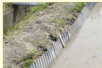
あぜ波板による補強
